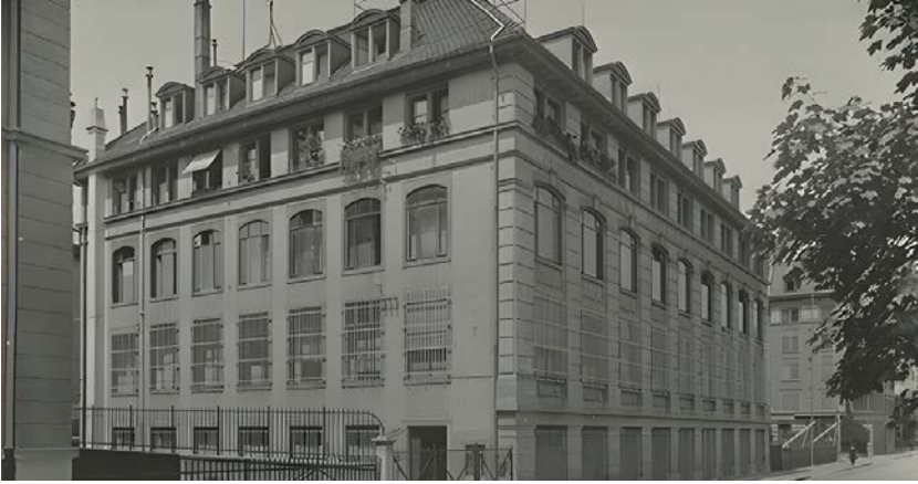
149. ábra: A svájci Pénzjegynyomda épülete, 1921. Forrás: Orell Füssli
